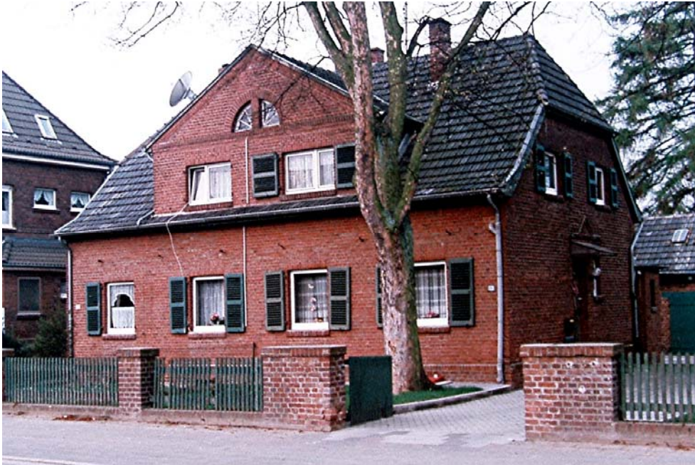
Bild 21: Doppelhaus Nr. 52 und 54 42
