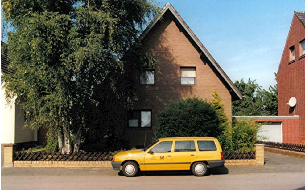
Bild 51: Haus Irisweg Nr.4 (Baujahr 1957; Umbauten 1980 bis 1985)
