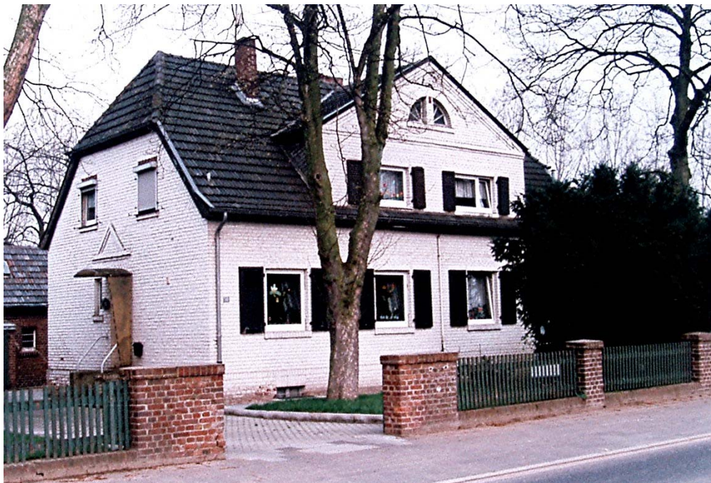
Bild 20: Doppelhaus Nr. 48 und 50 41
