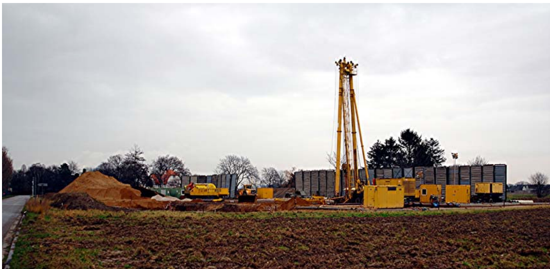
Bild 67: Bohranlagen im Jahre 2007 auf dem ehemaligen Gesolei-Siedlungsgelände; links die Straße "Zur Rauhen Eiche", im Hintergrund ist die Villa Nr. 71 zu erkennen.
