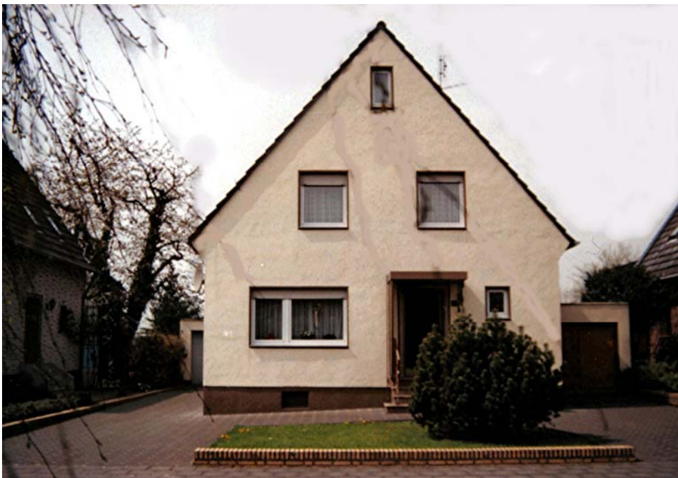
Bild 52: Haus Irisweg Nr.6 (Baujahr 1957; Umbauten 1978 bis 1985)
