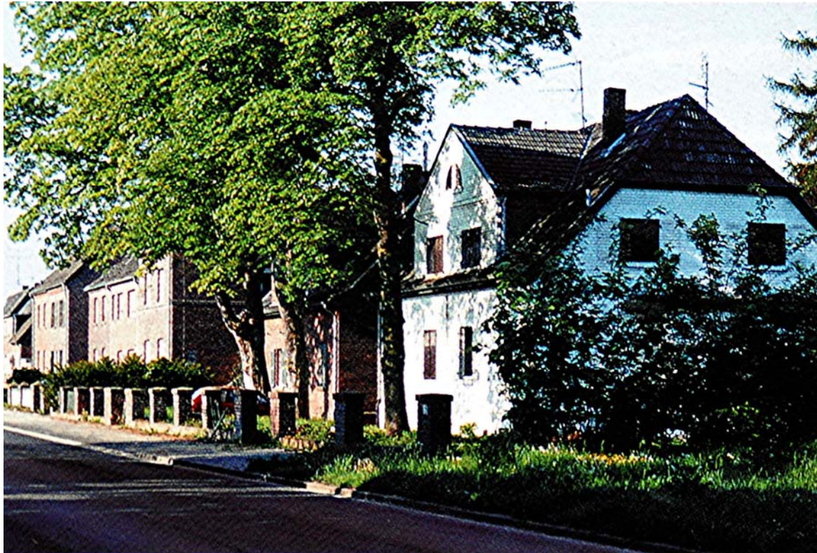
Bild 46: Die Dürener Straße in der Gesolei-Siedlung 79
