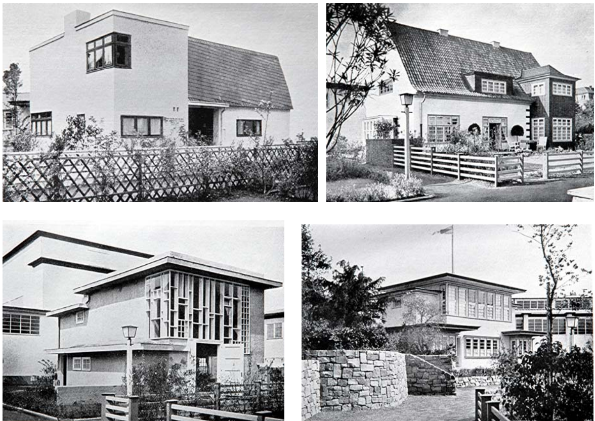
Bild 4: Musterhäuser auf dem Gesolei-Ausstellungsgelände
