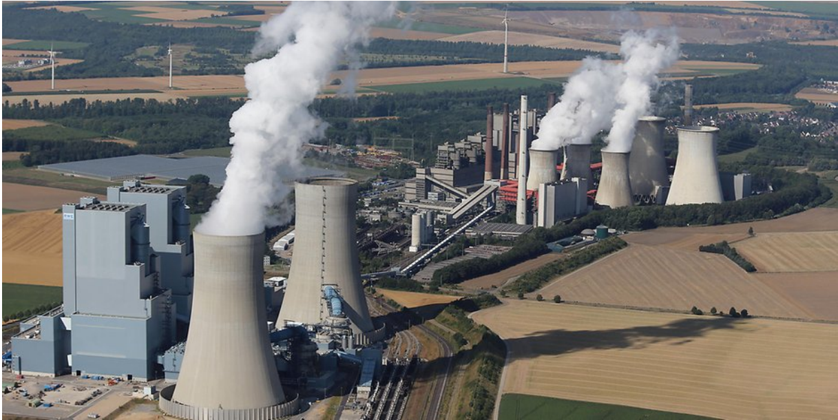
Das RWE-Braunkohlekraftwerk Neurath I und II in Grevenbroich-Neurath. Foto dpa
