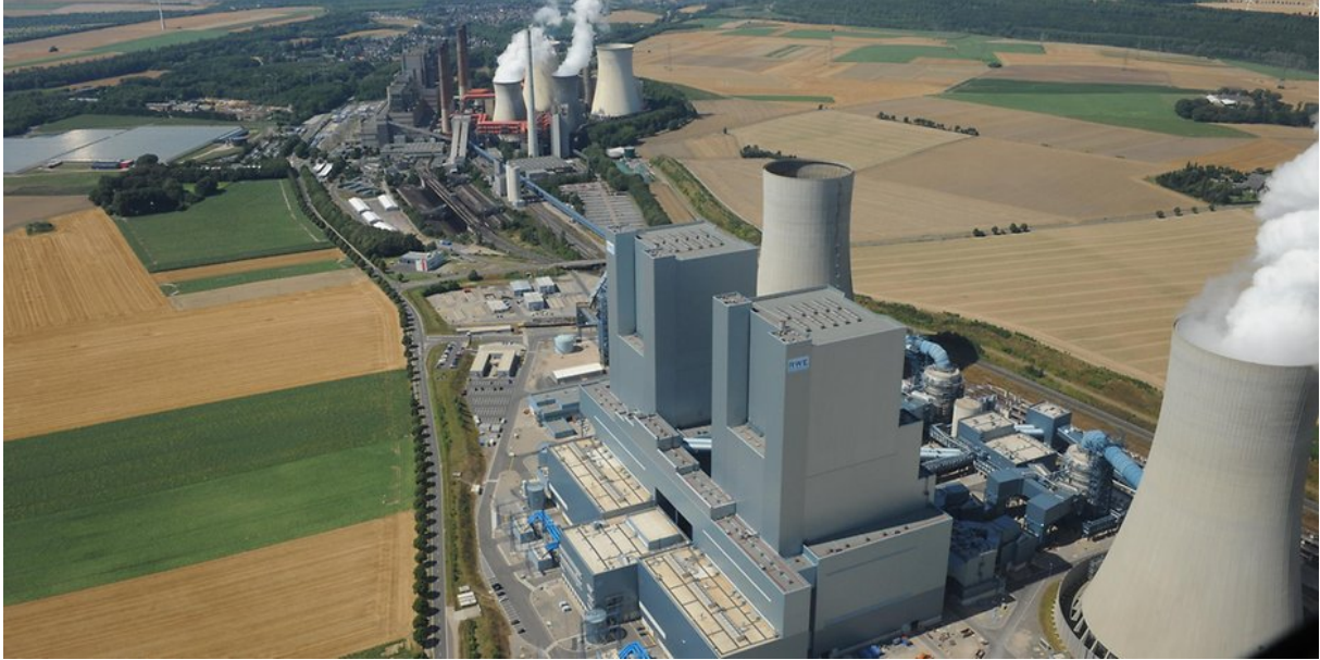
Kraftwerk von RWE. Foto: Udo Beissel
