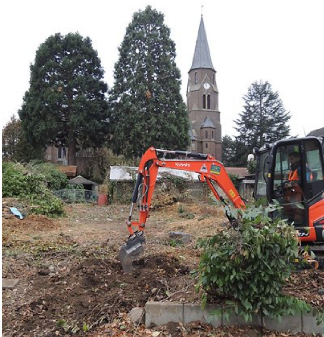
Immer näher rückten die Bagger an die Kirche. Foto Ralph Jansen
