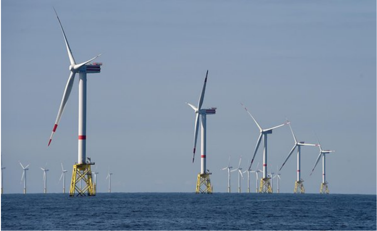
Ein vom RWE Energiekonzern vor Helgoland betriebener Offshore-Windpark. Foto dpa
