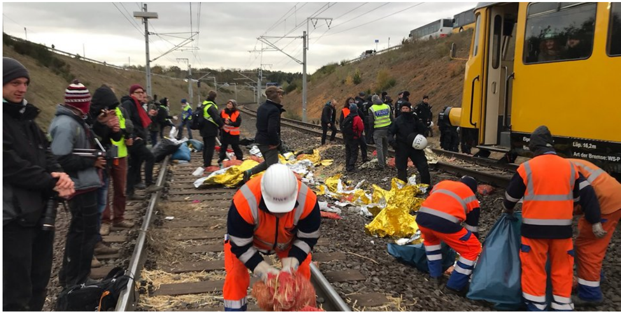
An der Hambach-Bahn laufen die Aufräumarbeiten. Foto: RWE
