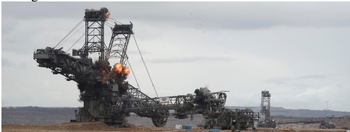
Am Freitagnachmittag hat RWE Power den Großbagger 259 nach Ausschachtung im Tagebau Hambach gesprengt. Foto: RWE Power
