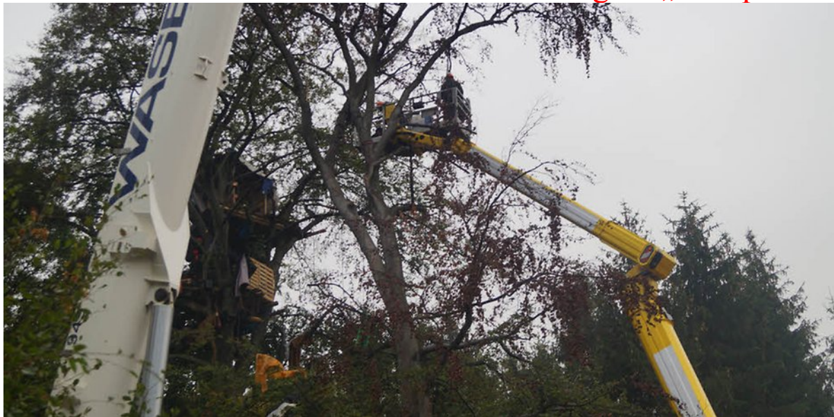
In „Lorien“ gehen die Räumungsarbeiten weiter. Foto: Führer
