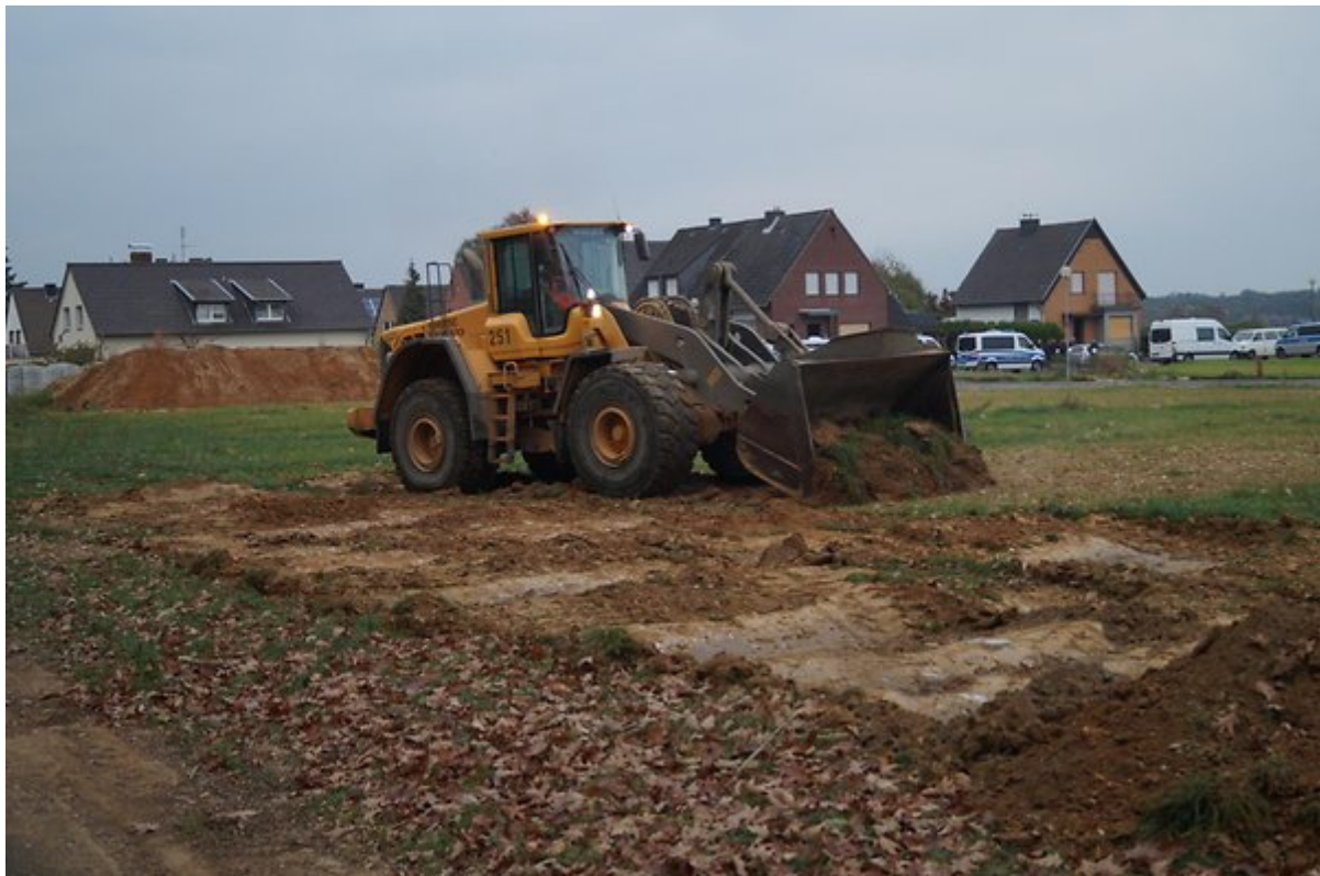
Auf dem Fußballplatz graben Bagger den Boden um. Foto Wilfried Meisen
