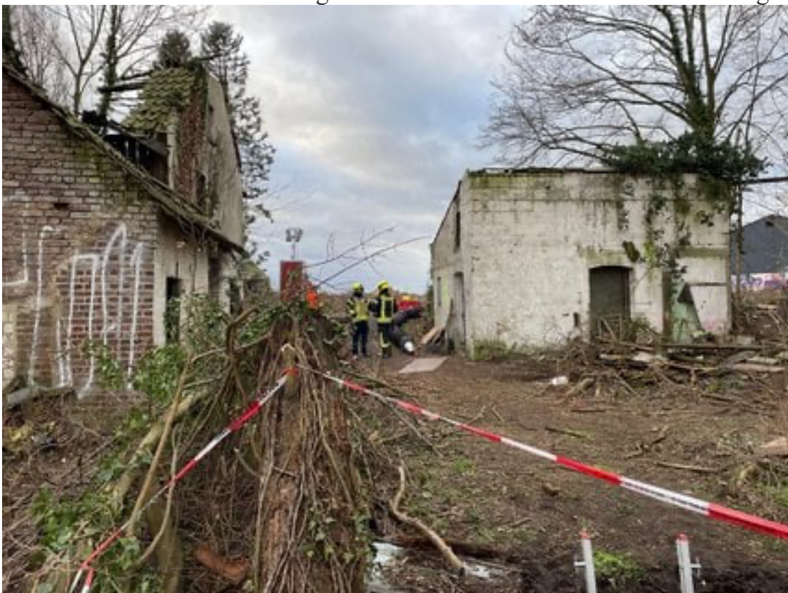
In dem weißen Gebäude (rechts) befindet sich der Eingang zum Tunnelsystem, in dem zwei Aktivisten ausharren. Bild: Christian Parth
